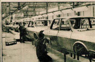
1. La chaîne de montage Renault 12 à l'usine Oyak-Renault de Bursa. 2. L'usine Oyak-Renault en vue générale : 20.000 Renault 12 par an.
