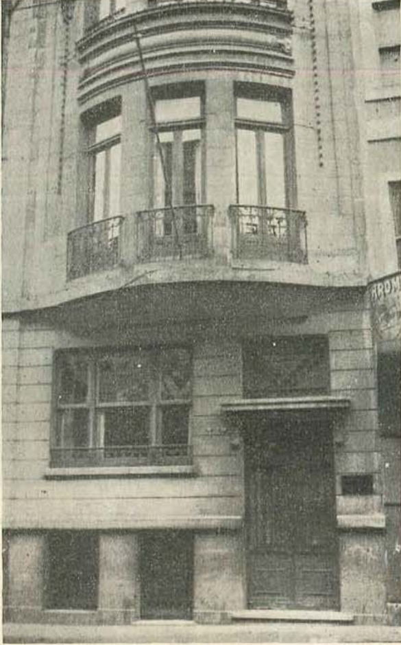
türk basın birliđi istanbul mıntakası merkez binası (beyođlu, istiklâl caddesi 42)
